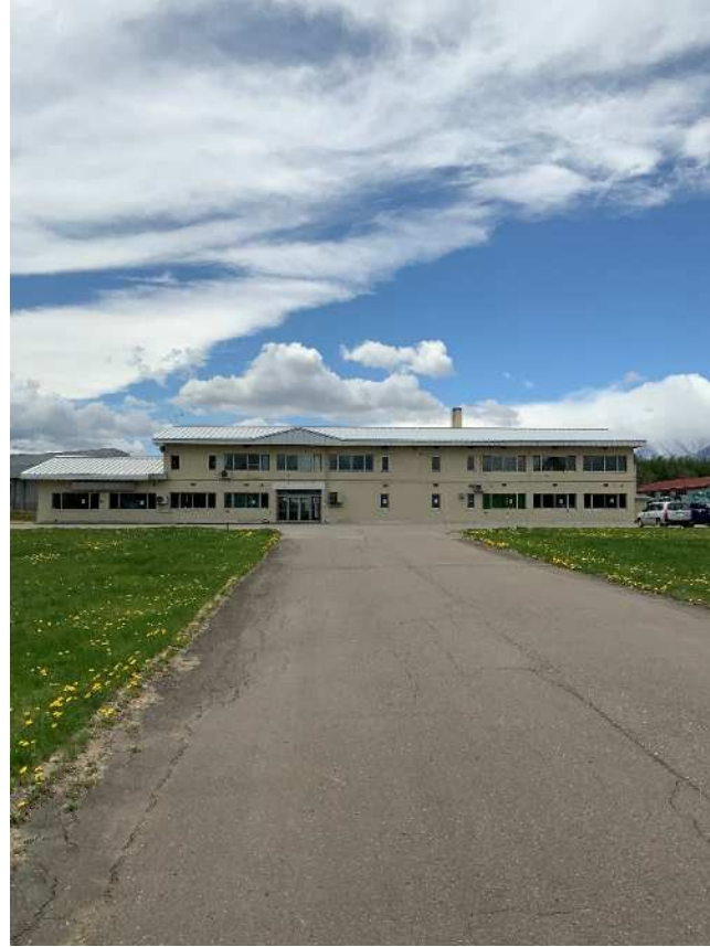
【事務所・黒にんにく製造棟】
